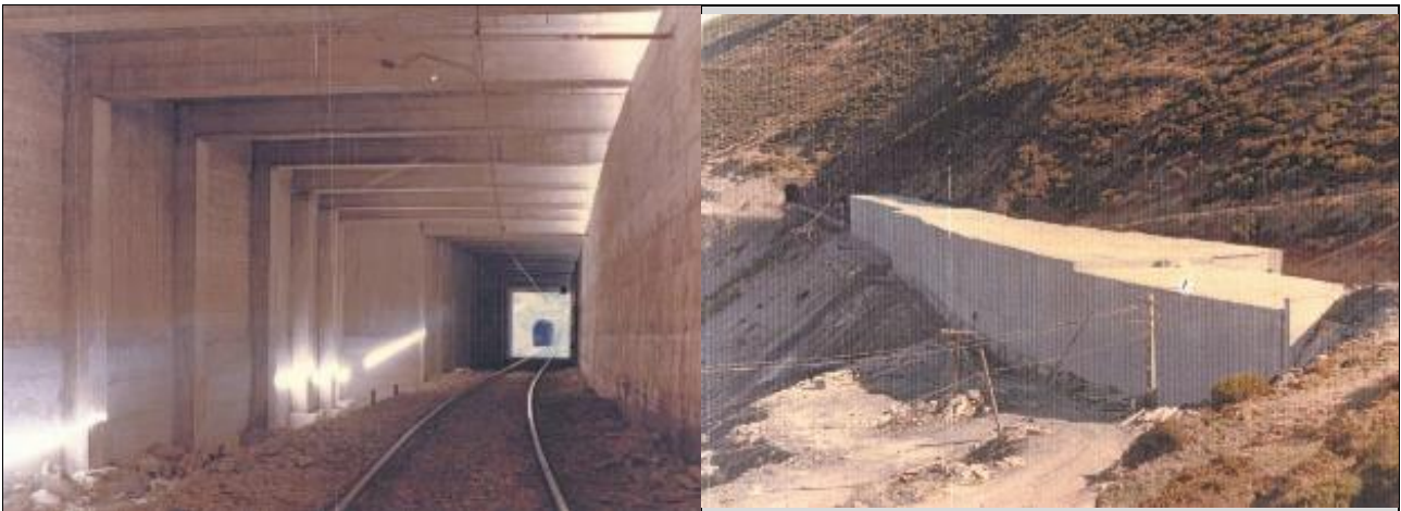
Nueva protección frente a avalanchas entre los túneles N° 20 “Corrolatienda” y 21 “El Serrón” (al fondo boca Sur, León).
