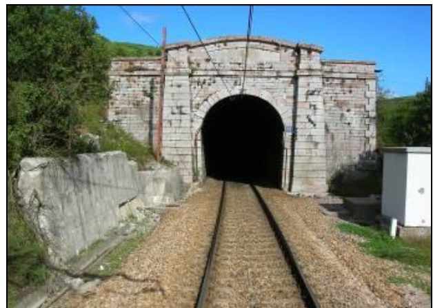
Boca lado León del túnel de “La Perruca”. (Hacar Rodríguez, Manuel. 2007)
