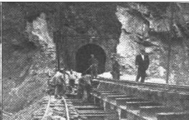
Detalle del apeo de los tramos metálicos sobre paquetes de carriles para la ejecución del terraplenado original del viaducto metálico de “Congostinas”.
