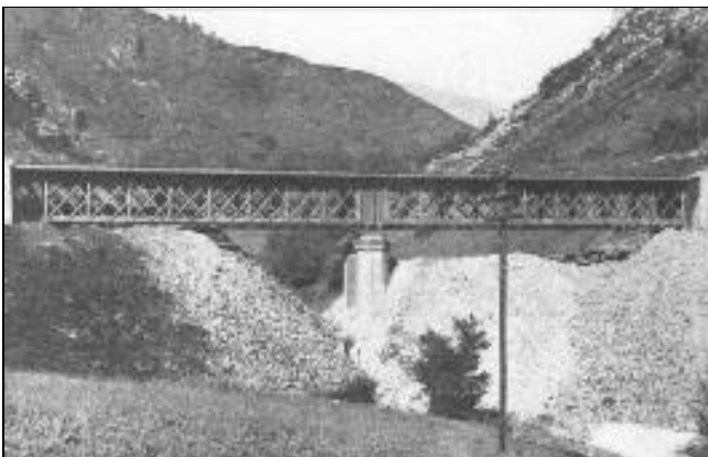
Original viaducto metálico de “Congostinas” (sería sustituido por una alcantarilla de desagüe y terraplenado sobre ella).
