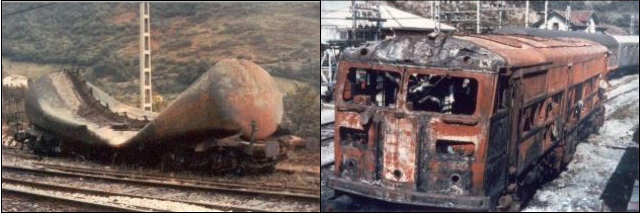
Túnel ferroviario de “Congostinas”. Accidente del 27 de Septiembre de 1978. (Díaz Pavón, Manuel Enrique. 1978)
