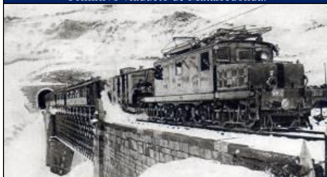
Paso de uno de los primeros trenes eléctricos por el primitivo viaducto de Matarredonda.
