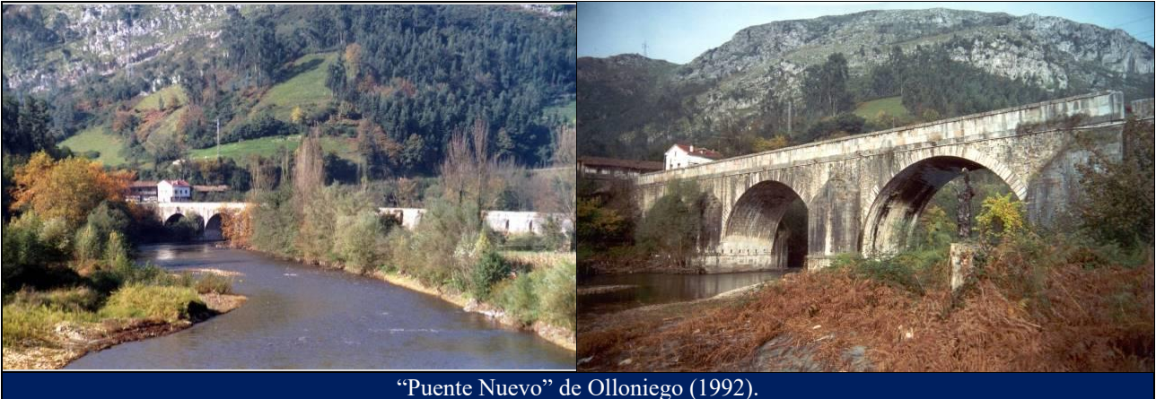
“Puente Nuevo” de Olloniego (1992).
