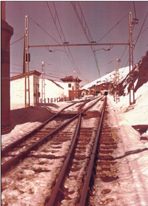
Estación de Pajares. Al fondo boca Sur (León) del túnel N° 20 “Corrolatienda”.
