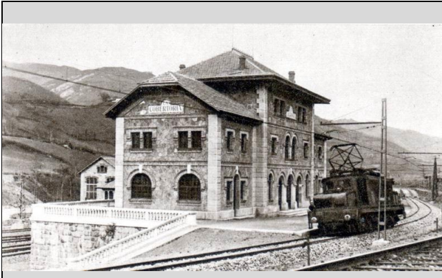
Apeadero de "La Cobertoria" en la "Rampa de Pajares".
